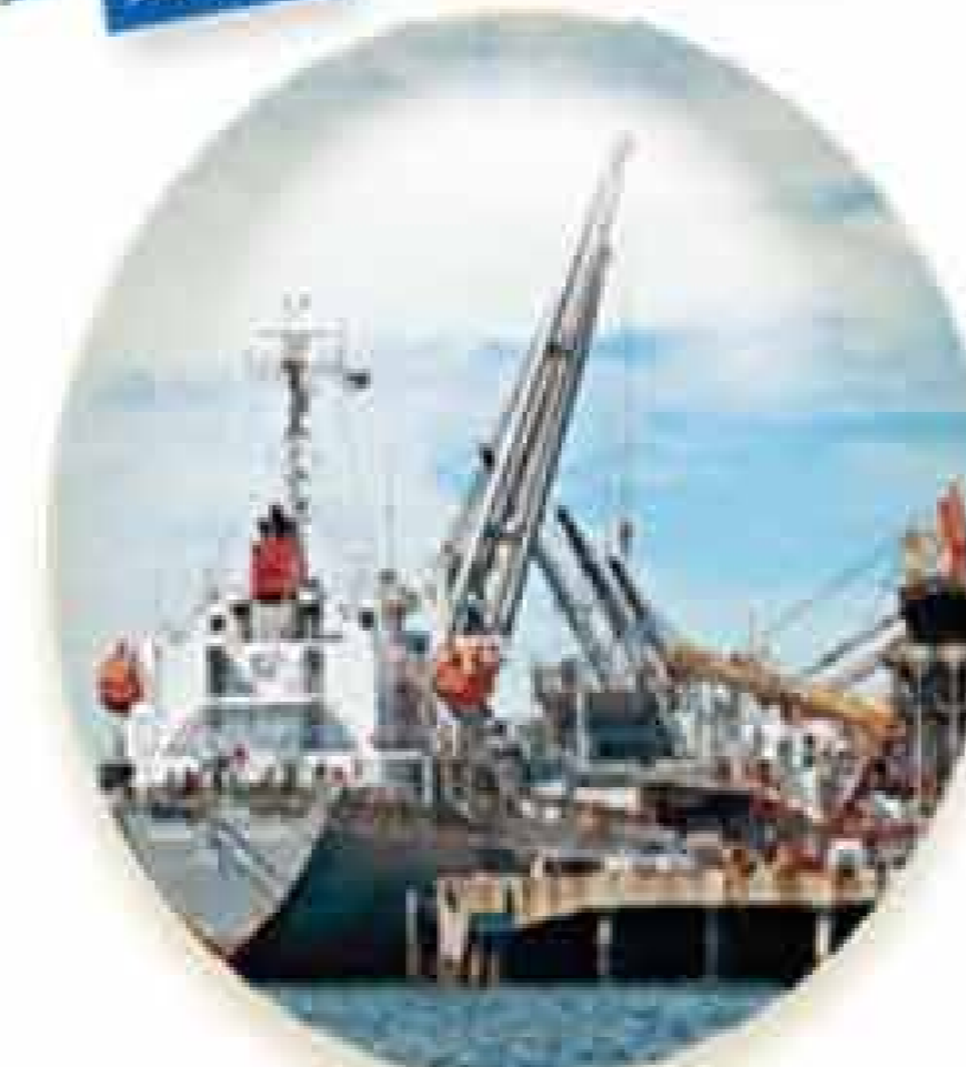
林查班深水港（上） 計畫成為全球前 20 大港口， 瑪瑙港（右） 增建儲存運送液態材料與天然氣的設備
